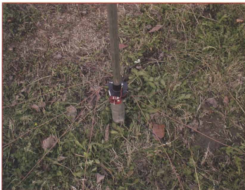
foto 4: base dell'antenna e radiali
